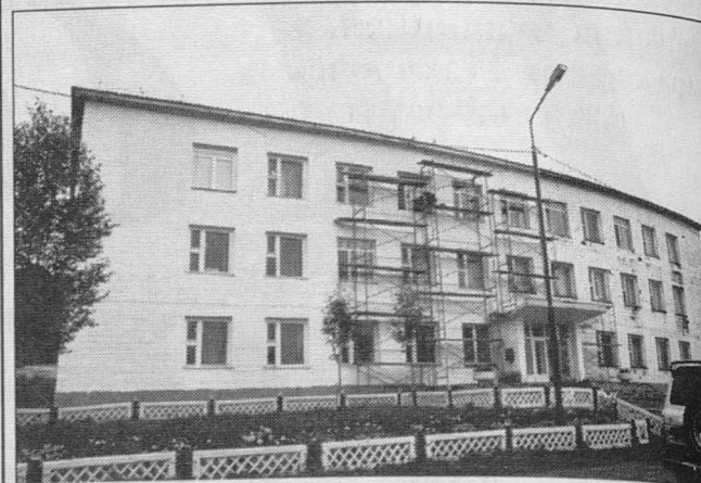
Ремонт фасада здания администрации
