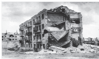
Август 1942 г. Развалины Сталинграда. Дом Павлова
