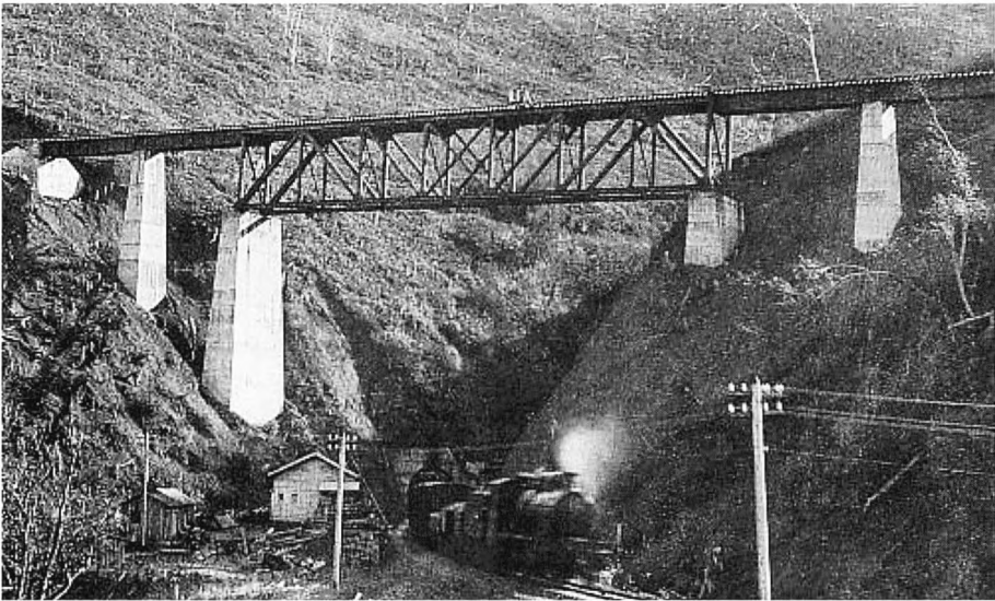
Мост в районе станции Такарадай
