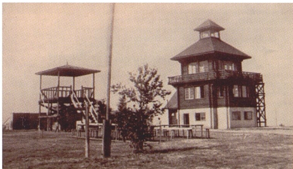
Смотровая башня на г. Обзорная. Фото 1920-х гг.
