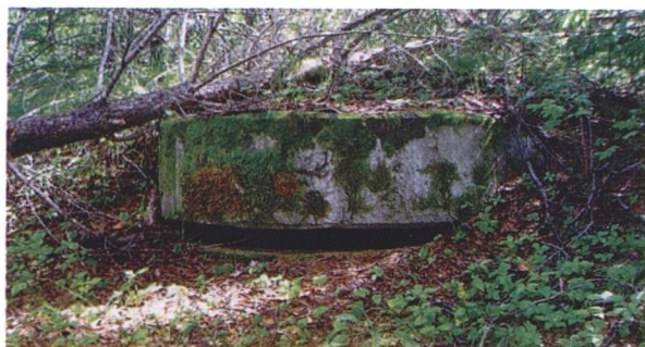
Смотровая щель железобетонного наблюдательного пункта
