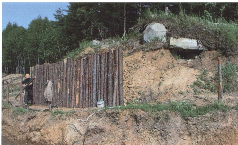
Работа по сохранению пулеметного дота на 209-м км трассы трубопровода
