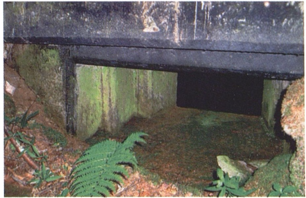
Ступенчатая амбразура пулеметного дота
