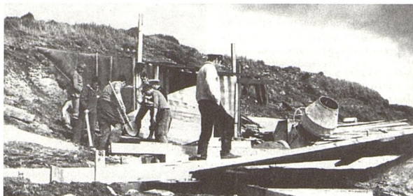
Строительство мемориала на горе Северной. Август 1975 г.
